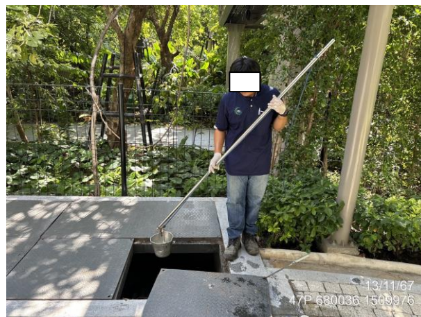
บ่อตรวจสอบน้ำสุดท้ายพร้อมตะแกรงดักขยะของแต่ละโครงการ
